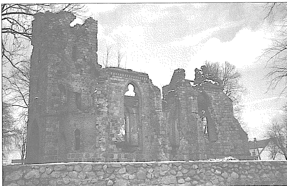
Ilustr. 4. Ruiny zniszczonego kościoła w Nętkowie
